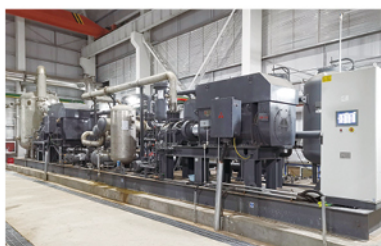
20 万吨食品级 CO 2 回收液化项目
