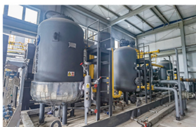
5 万吨 / 年食品级液体 CO 2 项目 螺杆二氧化碳压缩机
